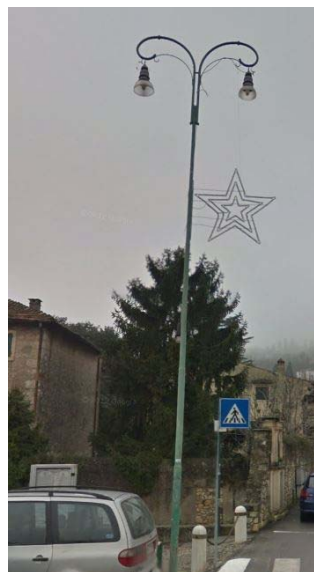
Fig. 3. Armatura stradale obsoleta da rimuovere e sostituire.
